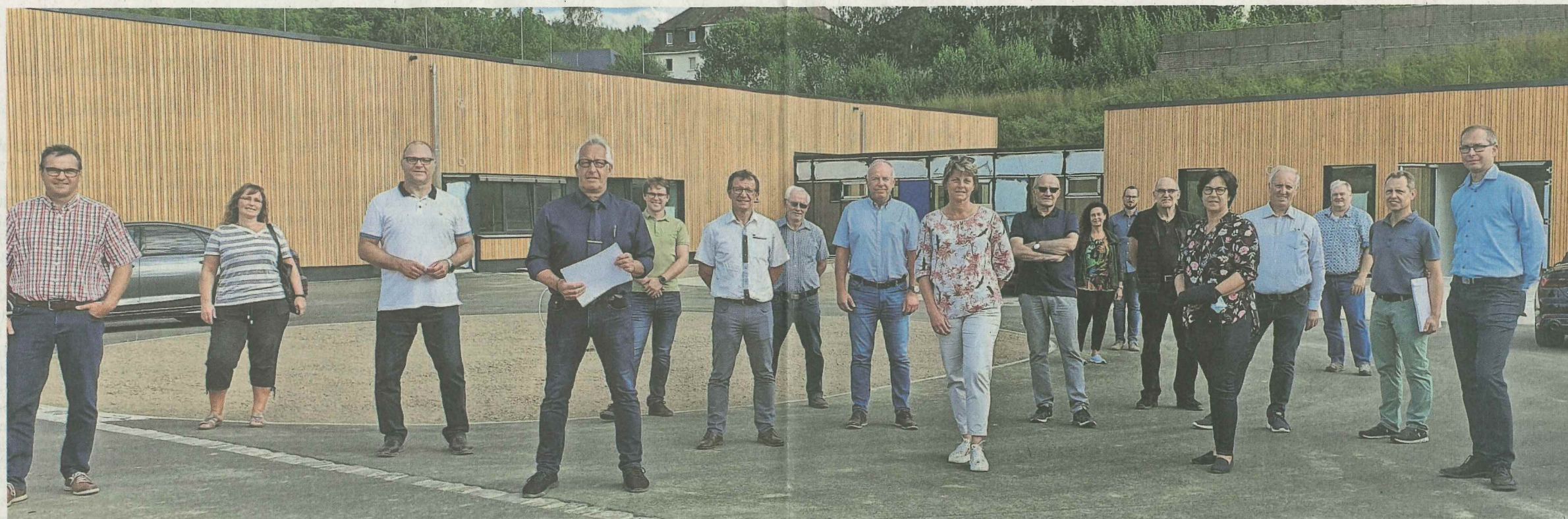
Bauleiter Hermann Begeest (Sechster von rechts) führte die Mitglieder des Bauausschusses und weitere Stadträte durch das neue Werkstattgebäude der Lebenshilfe (im Hintergrund) auf dem ehemaligen Schumann-Areal. Auch über den Bau des Wohnheims, der bald beginnen soll, sowie den Straßen- und Wegebau konnten sich die Rätinnen und Räte mit Bürgermeister Stefan Göcking (Vierter von links) an der Spitze informieren. Foto: Christl Schemm
